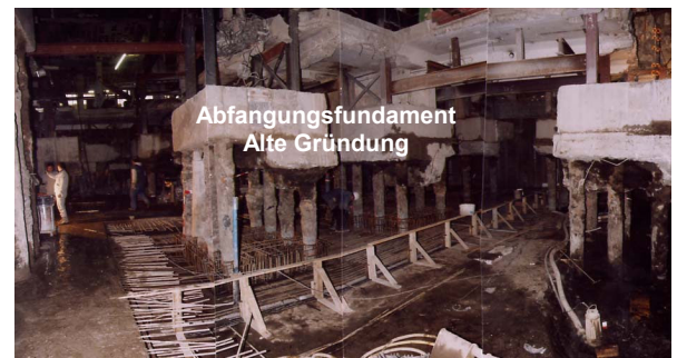
Untergeschoss im Bau
